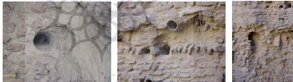
تصویر ۷: مجاری تخلیه سیلاب در بدنه سد
