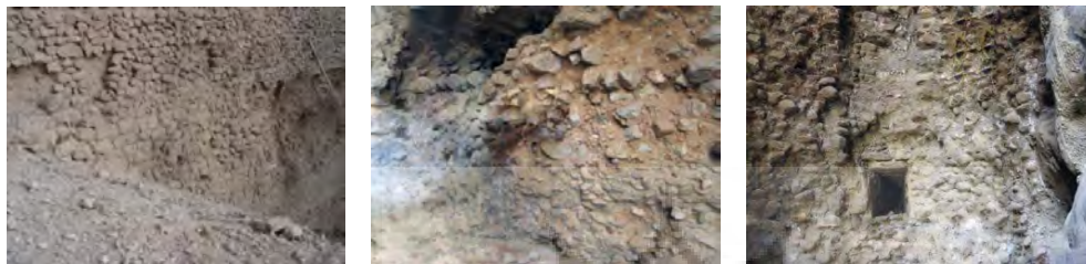
تصویر ۱۰: چگونگی استفاده از سنگ‌های رودخانه‌ای گردگوشه و گوشه‌دار نامنظم (تصویر راست و وسط) و منظم (تصویر چپ) در ترازهای مختلف بدنه سد
