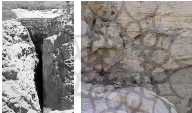
تصویر ۵: راست: نمای نزدیک حفرة خروجی؛ چپ: دورنمای وضعیت خروج آب از تکیه‌گاه راست در پایین دست سد (Emami 2014).
