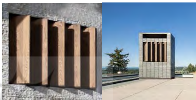
شکل ۳. تعبیه دریچه بالای اتاق
