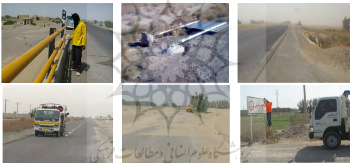
شکل ۳: تخریب تابلوها و سطح آسفالت و تعمیر و رنگ‌آمیزی تابلوهای صدمه دیده از توفان‌های گرد و غبار
