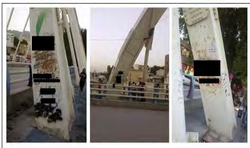
شکل ۱۱. دیوارنویسی ستادهای تبلیغاتی بر دیواره‌های پل‌ها
