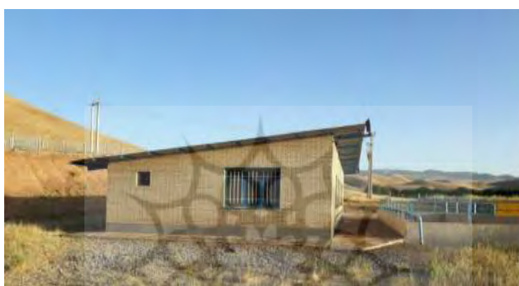
شکل ۱. ایستگاه پمپاژ آب روستای قمشه - درود فرامان
