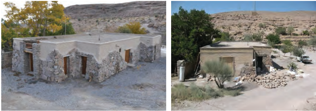
شکل ۱۸ و ۱۹. نمای ساختمان متروکه آموزش و پرورش قبل و بعد از بومی‌سازی منبع: مرکز اسناد پایگاه میراث جهانی میمند
