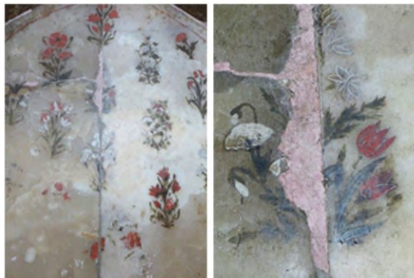
شکل ۷. نمونه ترک‌ها و شکاف‌های عمودی و افقی روی سنگ ازاره و پر شدن آن با ملات صورتی‌رنگ
