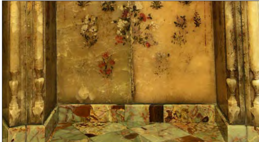
شکل ۴. سنگ‌های تعویض شده کف و کمر بند پایین ازاره
