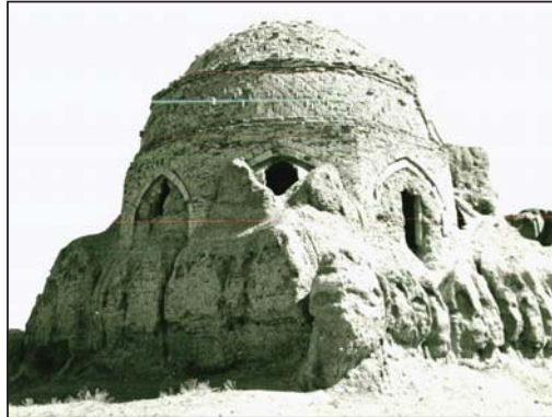
شکل ۴. گنبدخانه بنای رشت خوار، نمای از بیرون منبع: بی‌نام، ۱۳۵۵
