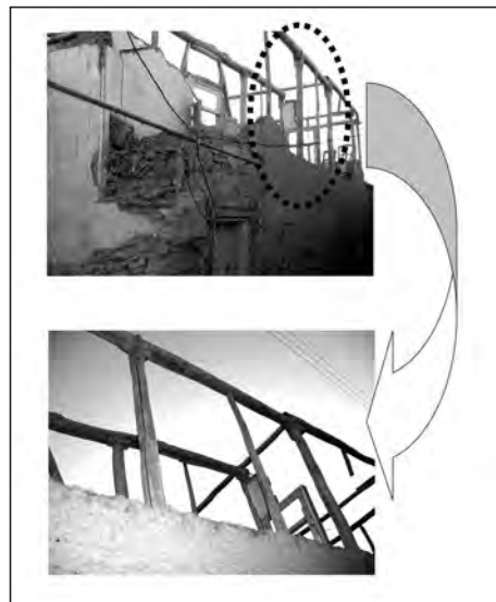
شکل ۴. بخشی از کلاف‌بندی چوبی یک خانه قاجاری، دربند ترکی‌ها، محله راسته‌کوچه
