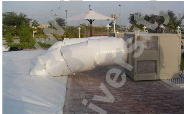
شکل ۶. نمونه پمپ‌های مکانیکی نصب‌شده قبل از اجرای سازه متکی بر باد. منبع: بروشور شرکت فندوله
