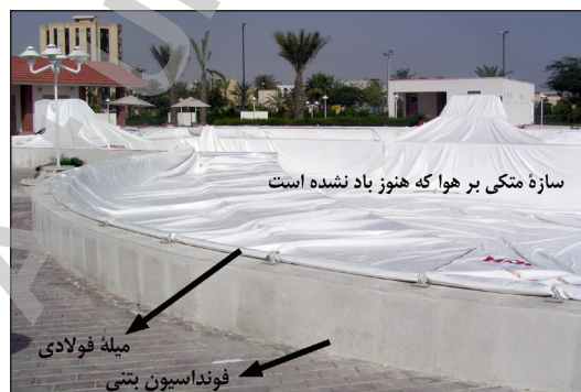
شکل ۱۱. سازه متکی بر هوا که پیش از اجرا، در نقاط پیرامونی مهار شده است منبع: بروشور شرکت فندوله - با توضیحات اضافی
