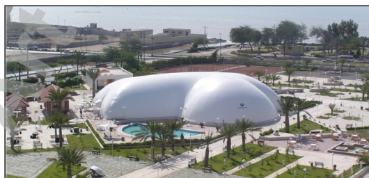
شکل ۲۵. استخر سرپوشیده هتل هرمز در بندرعباس، نمونه سازه متکی بر هوا
