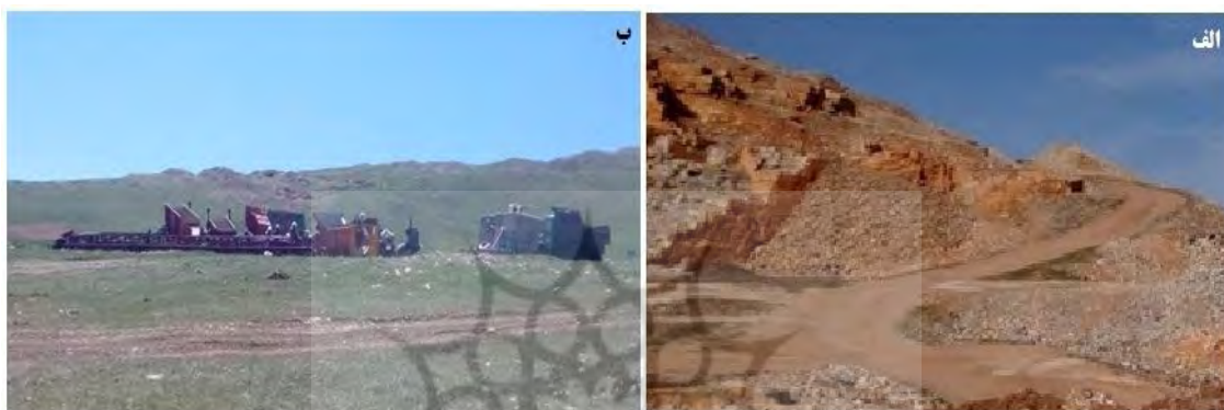
شکل ۷: الف) احداث راه‌های پر پیچ و خم برای دسترسی به معادن و ب-مراحل اولیه احداث کارگاه سنگ شکن
