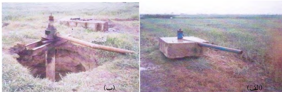
شکل ۱: لوله‌زایی در دشت گرگان (الف) در چاه پی‌زومتر عمیق (ب) در چاه عمیق بهره‌برداری (برگرفته از آرشیو شرکت آب منطقه‌ای استان گلستان)
