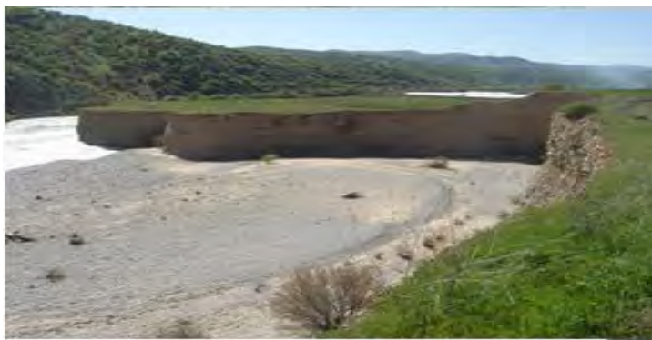
شکل ۷: فرسایش کناری در نتیجه سست بودن رسوب
