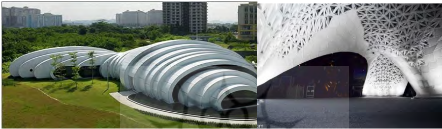
شکل ۷. سمت راست: بزرگ‌ترین پاولیون معماری چاپ سه‌بعدی شده جهان در شهر پکن، الهام گرفته شده از کرم ابریشم؛ سمت چپ: طرح کرم ابریشم در ساختمان نمایشگاه کوآلالمپور
