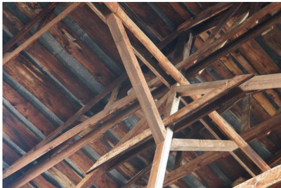
شکل ۱۹: جزئیات خرپای کارخانه نساجی شاهی
