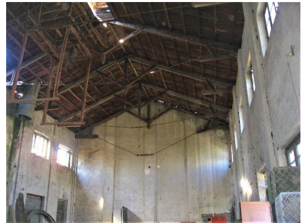
شکل ۲۶: خرپای کارخانه شالیکوبی بابل
