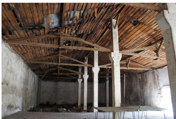
شکل ۲۱: خرپای کارخانه پنبه بابلسر
