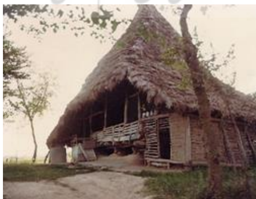
شکل ۵: سقف گالی پوش
