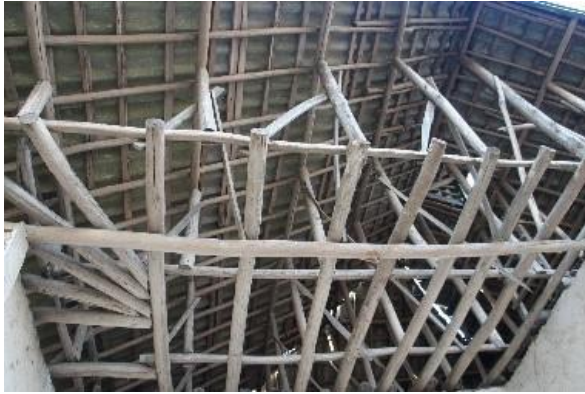
شکل ۷: سازه چوبی خانه‌ای در گیلان و چوب‌های گرده سقف
