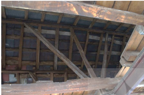
شکل ۱۶: نحوه قرارگیری تیرهای مورب و عمودی
