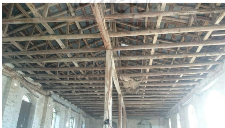
شکل ۱۳: سازه شیبدار ساختمان فلاطوری لاهیجان
