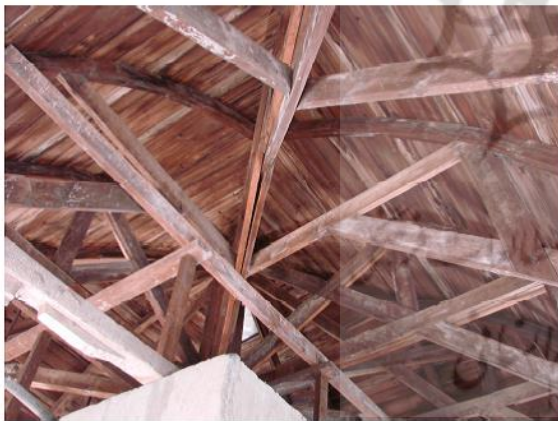
شکل ۳۰: خرپای ساختمان منبع آب کارخانه گونی بافی رشت
