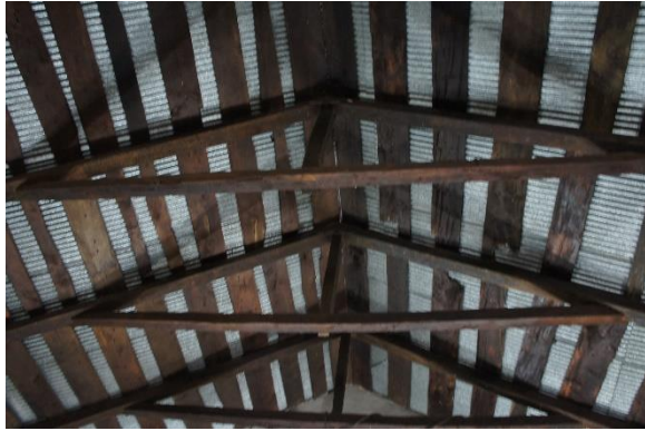
شکل ۲۴: خرپای کارخانه چای قلعه گردن
