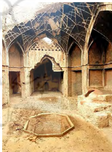
تصویر ۱۵: جزئیات تاق‌ها، تویزه‌ها و رسمی‌بندی در بناهای مزرعه‌ی بالاعباس‌آباد (نگارنده، ۱۴۰۰)
