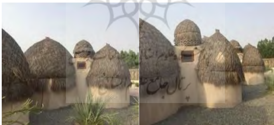
تصاویر ۱۸ و ۱۹ هتل کپری، منطقه قلعه گنج؛ (رضا صحت منش: ۹۷/۴/۲)
