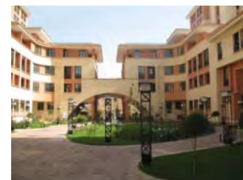
شکل ۲. بخشی از محوطه مجتمع زیتون
