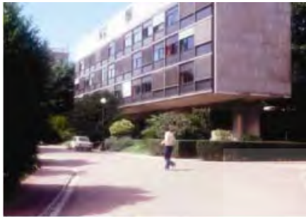
شکل ۱- نمونه سویس در نمایشگاه بین‌المللی پاریس، ۱۹۳۰، لوکوربوزیه قرارگیری ساختمان بر روی پیلوت، بهره‌گیری از پلان آزاد و نماهای شیشه‌ای مأخذ: Arnold et al, 2006
