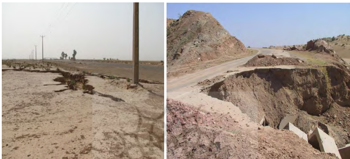
شکل ۲: تخریب جاده ها و خطوط انتقال نیرو و زمین های کشاورزی در منطقه تحقیق
