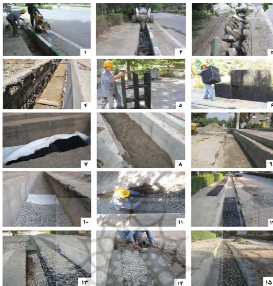
شکل ۱۲. مراحل اجرای پروژه شهرک سجاده، مأخذ: شرکت ماناصنعت ایران، ۱۳۸۹
