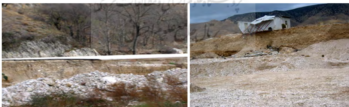
شکل ۴: تخریب ساختمان روستای دشت بر اثر سیل ۱۳۸۰ شکل ۵: تخریب جاده در پارک گلستان سیل ۱۳۸۰
