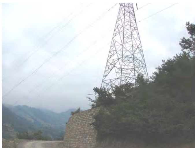
شکل شماره ۱۵- عکس تهدید دکل فشار قوی برق بر اثر پدیده لغزش
