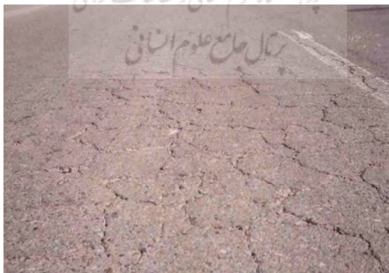
شکل ۲- تخریب روسازی آسفالت بر اثر یخبندان و تورم (محمودی، ۱۳۸۳)
