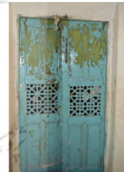
شکل ۱۹- کاربرد گره‌چینی در ساخت درب در خانه تاریخی عبداله‌بیک مسینایی (آرشیو شخصی محمدعلی بزرگمهر)
