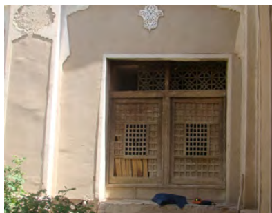
شکل ۲۷- طراحی و ساخت درب مبتنی بر ترکیب گره‌چینی مشبک و توپر در خانه تاریخی مهدی‌خان رفیعی (آرشیو اداره کل میراث فرهنگی خراسان جنوبی، ۱۳۸۲)
