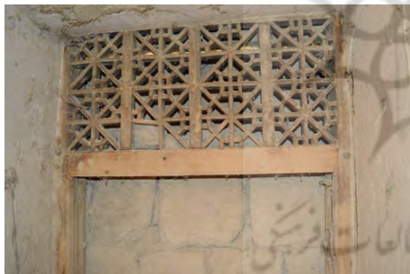
شکل ۲۲- بقایای پنجره گره‌چینی در خانه عبداله‌خان رفیعی عبداله‌بیک مسینایی (آرشیو شخصی محمدعلی بزرگمهر)
