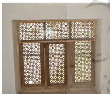
شکل ۱۵- ساخت ارسی مشبک شیشه‌دار در خانه عبداله بیک (آرشیو شخصی محمدعلی بزرگمهر)
