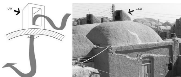
تصویر ۱. راست: تصویری از کلک در روستای قلعه‌نو؛ چپ: بیان گرافیکی نحوه ورود باد به داخل اتاق. مأخذ: حیدری، ۱۳۹۴.
