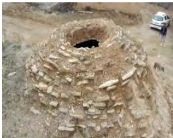
تصویر شماره ۶. چیدمان سنگ، خشت و گل در روی سقف از زاویه بیرونی زاغه (عکاس: پژوهشگر - بهار ۹۷)
