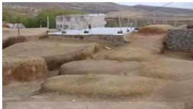
تصویر شماره ۱۰. سقف زاغه بعد از ترمیم به وسیله سواخ (عکاس: پژوهشگر - پائیز ۹۷)
