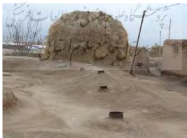
تصویر شماره ۱۳. پاچا از سقف زاغه در هنگام صبح که برای تمیز بودن هوا باز شده است (عکاس: پژوهشگر - بهار ۹۷)
