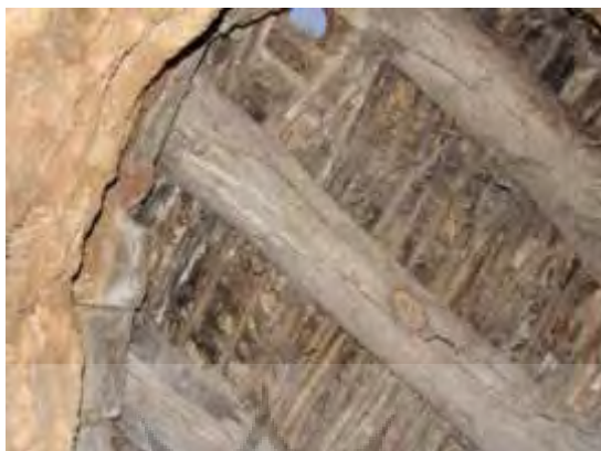
تصویر شماره ۴. سقف زاغه که با درخت سنجد درست شده است (عکاس: پژوهشگر - بهار ۹۷)
