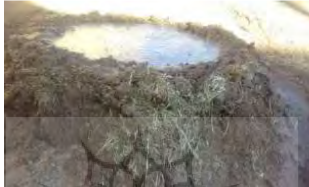
تصویر شماره ۸. در حال آماده کردن سواخ با خاک - کاه گل - نمک و آب زاغه (عکاس: پژوهشگر - بهار ۹۷)
