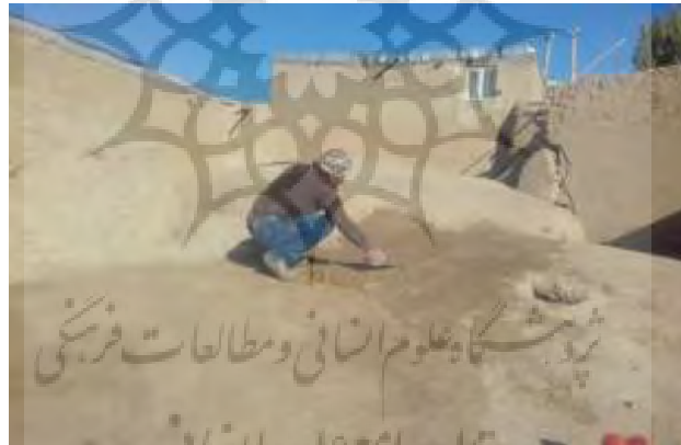
تصویر شماره ۹. استادکار در حال کشیدن سواخ با ماله بر روی سقف زاغه (عکاس: پژوهشگر - پائیز ۹۷)
