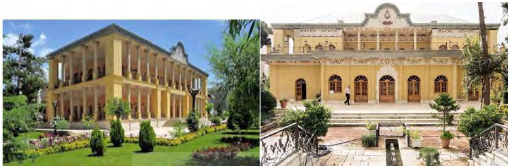
Fig. 7: Ein al-Dowleh Mansion (Municipality of District 4, 2016)
