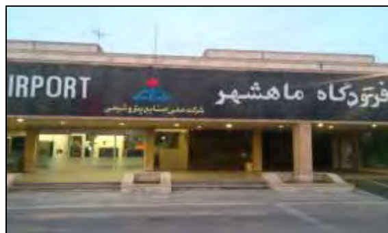
شکل ۴. وجود رمپ در ابتدای ورودی فرودگاه شهر بندر ماهشهر برای استفاده از صندلی چرخدار
