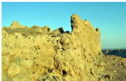
تصویر ۱۸. بخش‌هایی از دیوار قلعه نسک دهستان کشیت (اسکندری، ۱۳۹۰: ۶۳۰)
