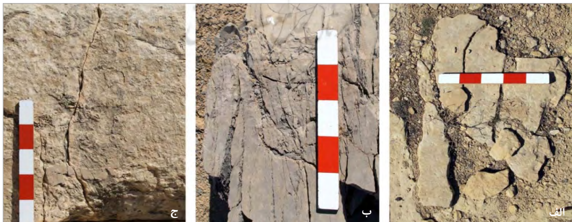
تصویر ۲. الف: سنگ کبود به کار رفته در کف زیرین کاخ اختصاصی، بخش‌هایی از آن متلاشی شده و بخش‌هایی به شکل خاک درآمده‌اند. ب: سنگ سیاه در کاخ اختصاصی، این سنگ در راستایی همسو با لایه‌های رسوب‌گذاری دچار تخریب شده است، ج: سنگ کرم‌رنگ پلکان مقبره کوروش، به نظر می‌رسد فرسایش آن بیشتر در لایه‌های سطحی بوده و همچنین بر اثر نیروهای فشاری بلوک‌های سنگی قرار گرفته در طبقه‌های فوقانی پلکان، دچار شکستگی شده است. (نگارندگان)
