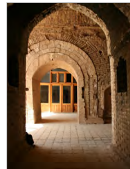
تصویر ۱۰. تقویت تویزه خشتی (محور K، بین ۳ و ۴) به وسیله آجر در دوره سلجوقی (مهندس نژاد)
