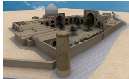
تصویر ۲. تصویری سه‌بعدی از مسجد؛ اجزاء اصلی مسجد شامل: گنبدخانه و ایوان جلوی آن در وسط؛ منار در جلو؛ ایوان غربی در سمت راست تصویر (شرکت مهندس مشاور هفت خشت پارس)
