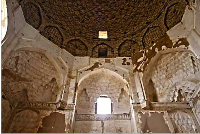
تصویر ۸. چگونگی تبدیل مربع به دایره گنبد (نگارندگان)
