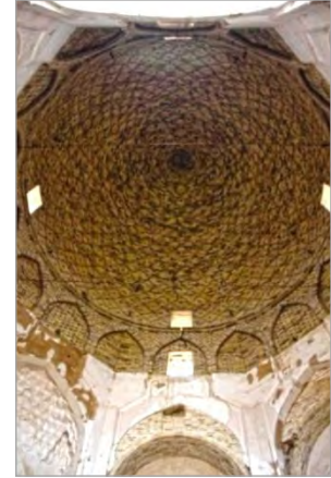
تصویر ۷. پوسته داخلی گنبد با ۸ باریکه تاق (نگارندگان)
