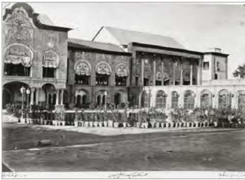
تصویر ۲. عکسی تاریخی از عمارت دیوان خانه و سفره خانه (آلبوم خانه کاخ گلستان)
