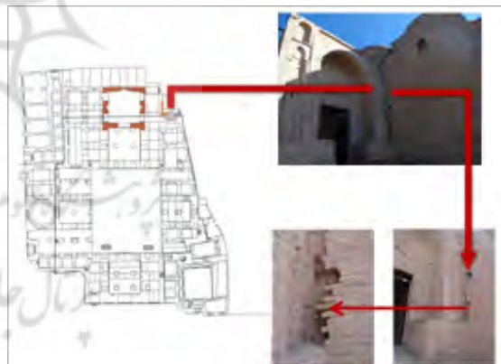
تصویر ۲۰. یک‌پارچه نبودن اتصال میان دو دیوار (نگارندگان)
