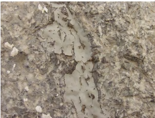
تصویر ۹. رزین استفاده‌شده برای مرمت در حال جداشدن از سنگ (نگارندگان).
