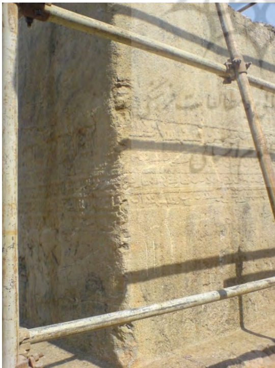
تصویر ۱۷. سنگ نوشته خرم آباد پس از استحکام بخشی با آب آهک و پوشش دهی با پارالوئید B72 (نگارندگان).
