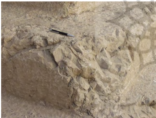
تصویر ۷. شکستگی و جداشدن قطعه‌هایی از سنگ و جدایش لایه‌های زیرین در پایه اثر (نگارندگان).
