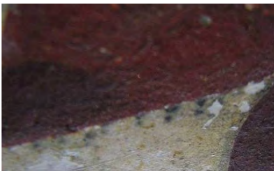
تصاویر ۱۶. نمایی از تزئینات طاق نماهای زیر گنبد که به صورت گرته کردن، قرص کردن یا آب مرکب و رنگ گذاری اجرا شده است (مأخذ: نگارندگان)
