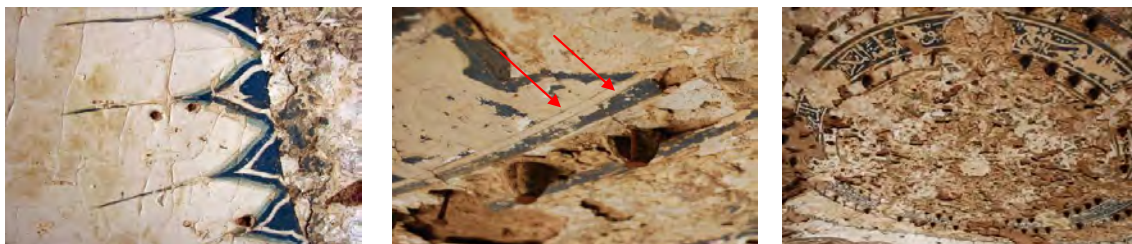
تصاویر ۲۰. نمایی از شمشه و اجرای دایره شمشه با خراش ظریف، نقوش انتهایی شمشه و قلم‌گیری نقوش با رنگ مشکی بسیار رقیق (مأخذ: نگارندگان)
