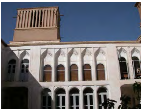
۱۶. یکی از بادگیرهای خانه رسولیان یزد (ماخذ: ذاکرعاملی)
