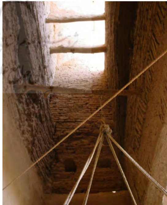
۱۴- داخل کانال بادگیر خانه سمیعی میبد. در طرفین بدنه بادگیر داغ طاق قدیمی که برچیده شده است مشهود می‌باشد. (ماخذ: اسفنجاری و ذاکرعاملی، ۱۳۸۵: ب: ۱۸).
