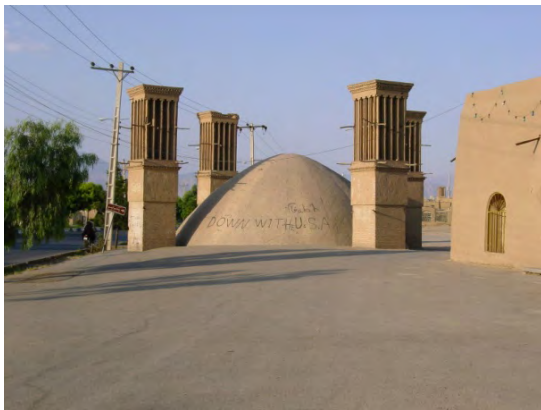
۲۰. آب انبار رستم گیو یزد با بادگیرهای چهارسویه (ماخذ: ذاکر عاملی)
