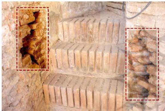
شکل ۴. نمایی از گمانه S1 در محل پلکان شرقی که اتمام نما در کادر سمت راست مشهود است.
