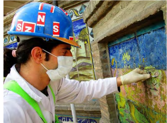
شکل ۹. کاشی‌مقوش به شیر و خورشید در محل کتیبه‌های سردر باغ ملی که در دوره انقلاب برای ممانعت از تخریب با رنگ پوشانده شده بودند و هنگام مرمت‌های سال‌های ۱۳۹۵-۱۳۹۶ از زیر پوسته محافظ خارج شدند.
