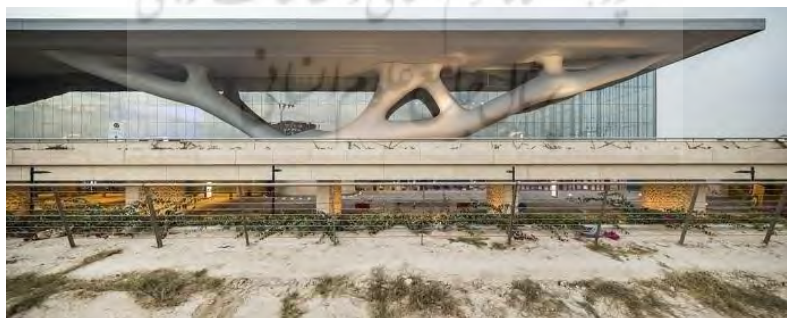
شکل ۳) طراحی پایه‌های سایه‌بان مرکز انجمن بین‌المللی قطر با استفاده از بهینه‌سازی توپولوژی [۱۸]
