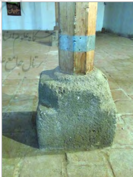
تصویر ۶. قرارگیری ستون چوبی بر روی پایه سنگی به صورت فاق و زبانه مخفی (نگارندگان).
