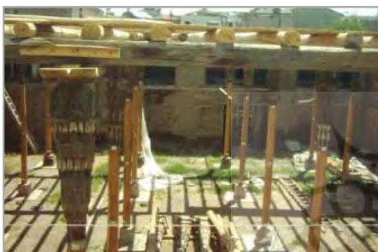
تصویر ۲. تیرریزی سقف شبستان بزرگ هنگام بازسازی اساسی (خیری، ۱۳۸۵: ۳۱۴)
