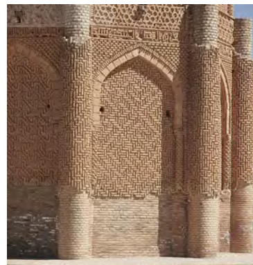
تصویر ۴- برج شرقی خرقان با استفاده از طاق‌نمای تزئینی، هر ضلع محل اجرای نقشی متفاوت قرار گرفته است (نگارنده، ۱۳۸۰)
