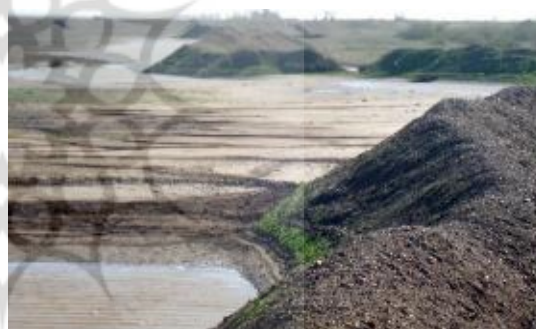
شکل ۱۸. تجمع رسوبات بالادست در پشت خاکریزها
