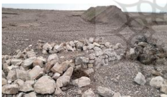
شکل ۱۷. شکست خاکریز به طرف اراضی و تأسیسات پائین‌دست
