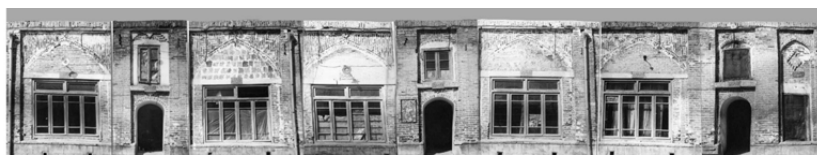
تصویر ۱۵: نقشه و تصویر مربوط به قبل از تخریب حجره‌های ضلع غربی (آرشیو اداره کل میراث فرهنگی، گردشگری و صنایع دستی استان آذربایجان غربی)
