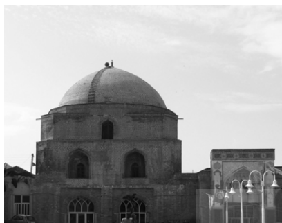
تصویر ۲۴: گنبد کاشی‌کاری شده در دوره پهلوی (Wilson 1937, 39)؛ ب. گنبد با پوشش ورق گالوانیزه (شیروانی) آرشیو اداره کل میراث فرهنگی، گردشگری و صنایع‌دستی استان آذربایجان غربی؛ ج. وضعیت موجود گنبد با پوشش آجری
