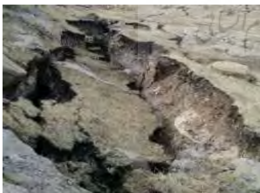
ت) شکاف‌های عرضی عمیق مله کبود-قورچی باشی
