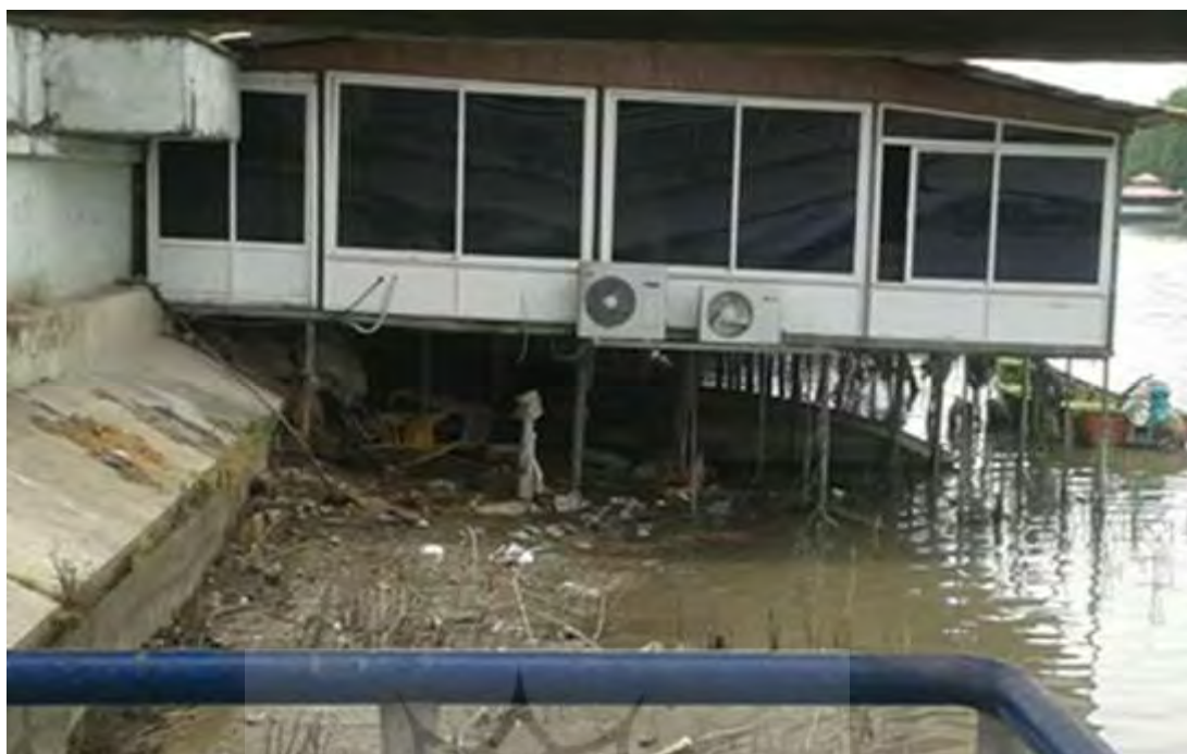
شکل ۳. ساختمان کاربری تفریحی متروک در بستر رودخانه و انباشت رسوبات در زیر آن جذابیت و سرزندگی
