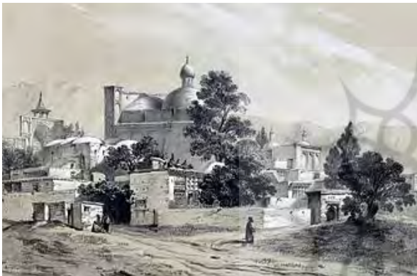
تصویر ۲: تصویر دورنمای بنا در اسناد تاریخی (آرشیو اداره میراث فرهنگی شهرستان بروجرد).
