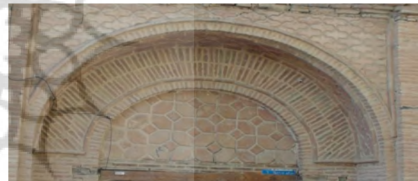
تصویر ۲: نمونه‌هایی از تزیینات آجرکاری استفاده‌شده در خانه ضیائی و زهرائی (مأخذ: نگارندگان).
