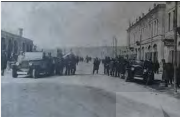
تصویر ۲. پیاده‌گذر تربیت در زمان احداث. مأخذ: جدیدالاسلام، ۱۳۹۱: ۶۵.
