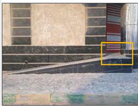
تصویر ۱۱. رمپ نامناسب و غیراستاندارد
