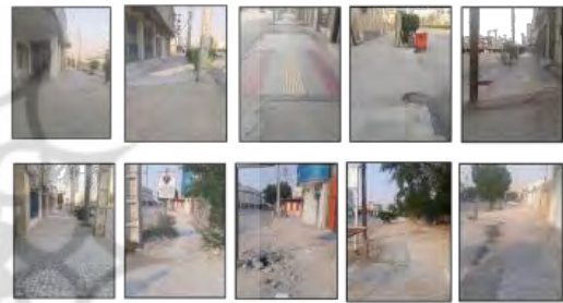
تصویر ۴. کف‌سازی نامناسب و نامتوازن و وجود مصالح متنوع در پیاده‌رو
